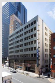
NMF新宿南口ビル
